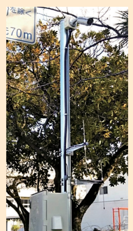
校門に設置された防犯カメラとICタグ読取センサー
