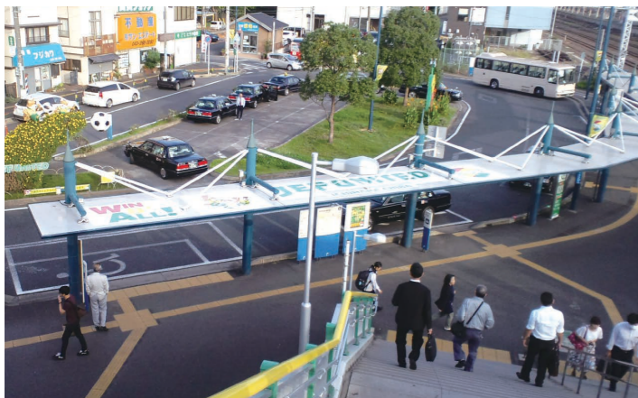
バスシェルター屋根へのラッピング
