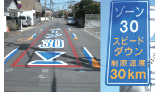
路面標示 (ゾーン30)
