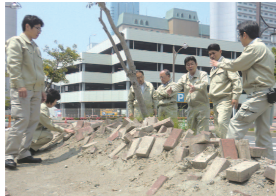
美浜区の液状化被害(2011.5撮影)
