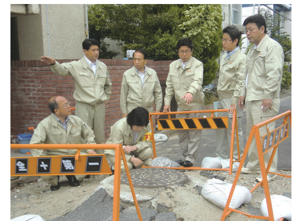
市内の液状化被害現場へ
